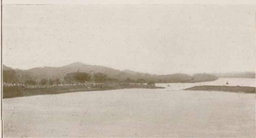
Voladura del Dique Gamboa, que ocasionó la unión de las aguas en el Canal de Panamá
